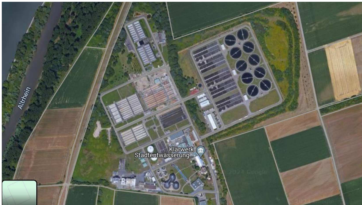
Abb: Klärwerk Mannheim nördlich von Sandhofen, Ausschnitt aus Google Maps
