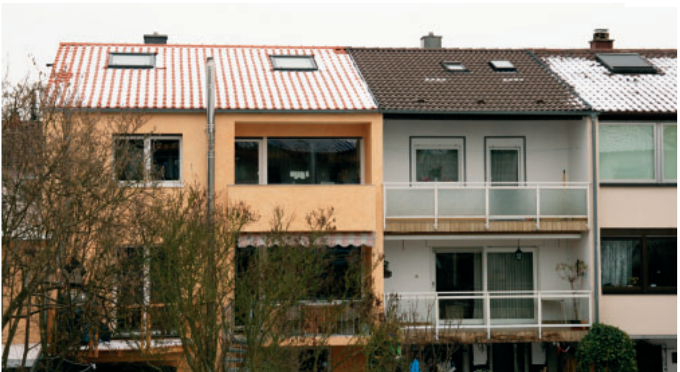
In der Mitte schlechte, rechts und links gute Wärmedämmung unter den Dachflächen.
