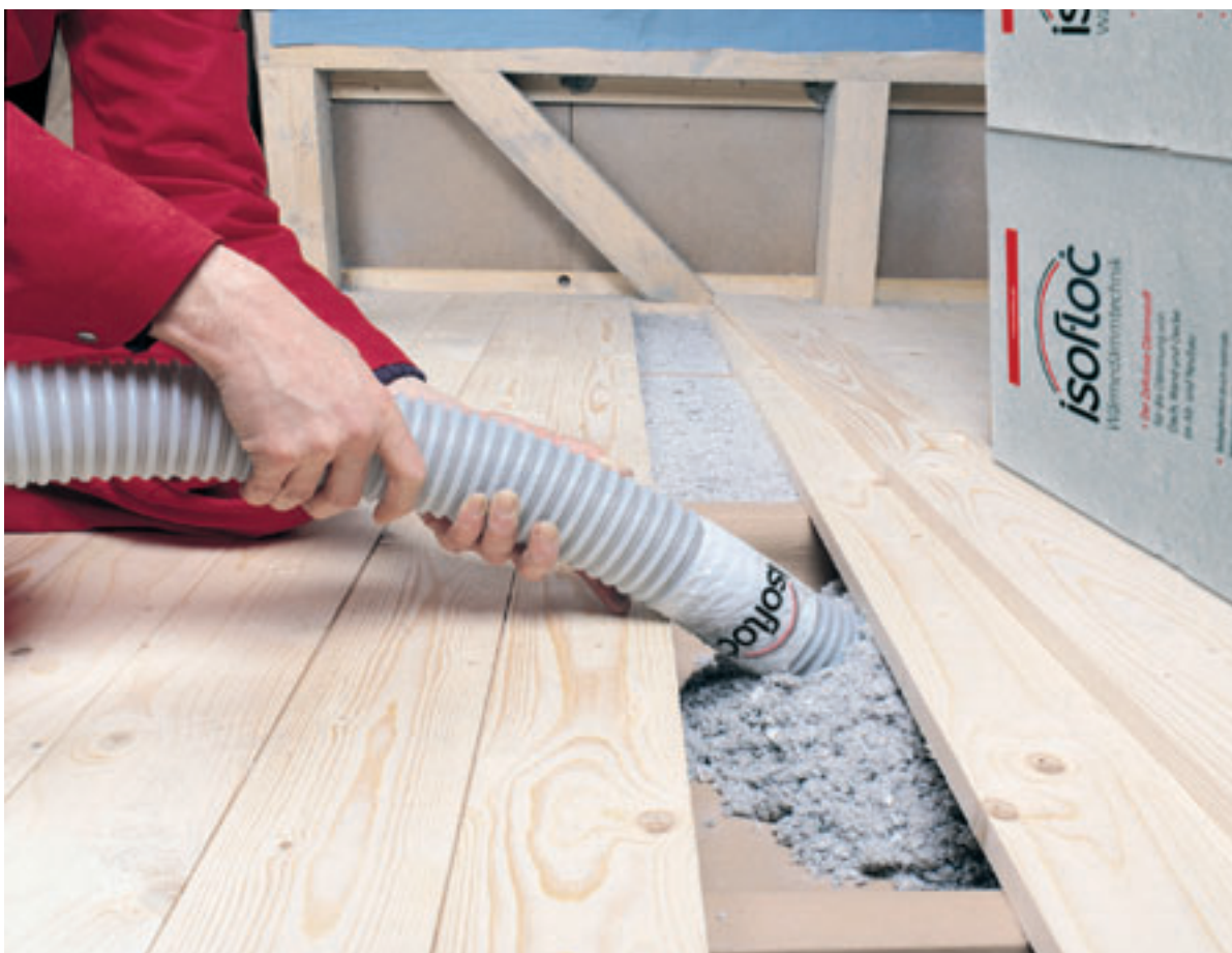
Nachträgliches Einblasen von Isofloc in Hohlräume
