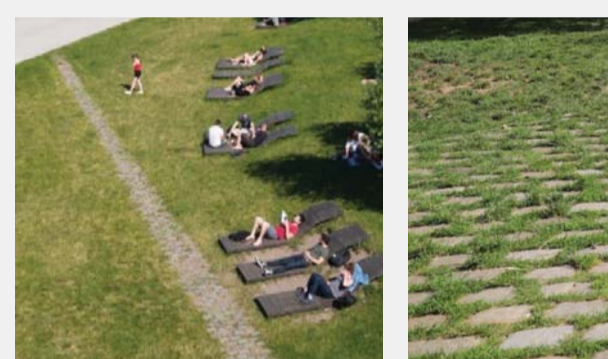
NEBENWEGE AUS RASENFUGENPLASTER
