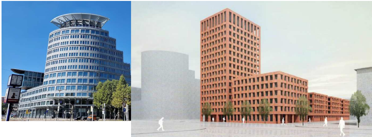
Abbildung 5 und 6: Links: Bestehender Büroturm auf der gegenüberliegenden Straßenseite der Augustaanlage, Quelle: Google Maps, Rechts: Perspektive vom Europaplatz (von Osten) auf den geplanten Neubau. Quelle: Begründung S. 21. Im linken Bereich des neuen Gebäudekomplexes der geplante 16stöckige Turm.
