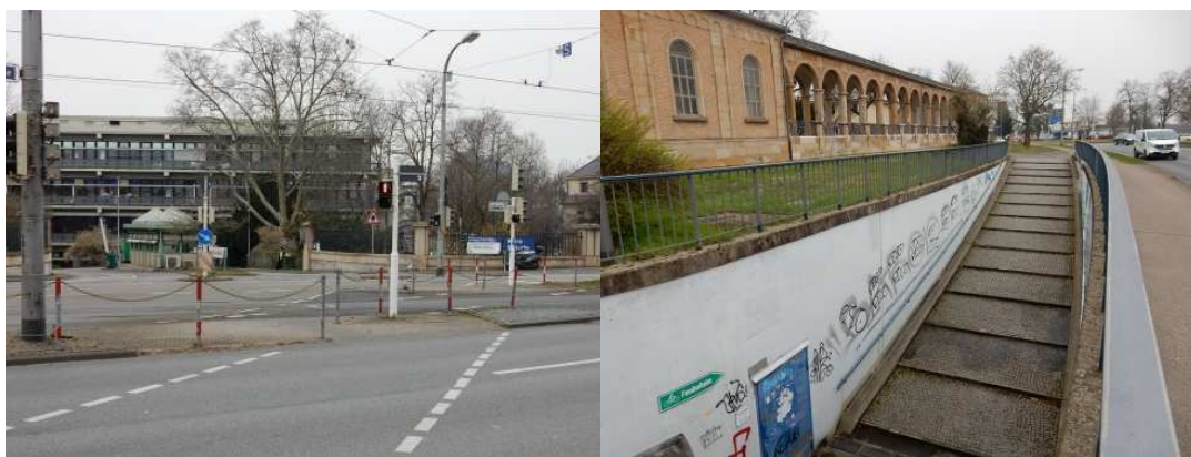
Foto links: Ampelquerung der Röntgenstraße Höhe Cheliusstraße mit Ketten, rechts: Unterführung der Röntgenstraße am Hauptfriedhof mit Stufen
